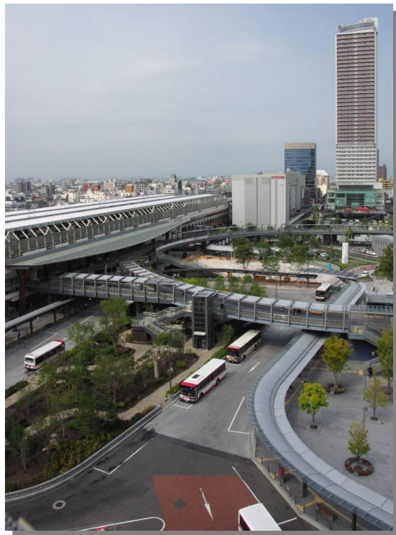
【岐阜駅北口駅前広場】
