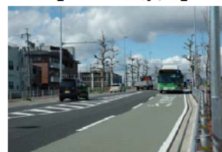
BRT導入空間の整備
