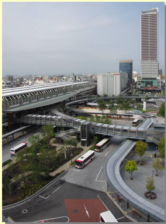
【岐阜駅北口駅前広場】
