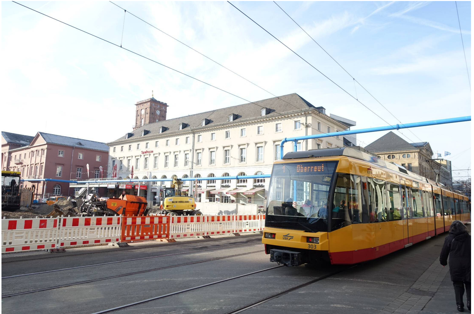
2015. 11. 24. 撮影 新たな地下路線工事中
