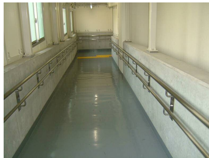
スロープ設置例
