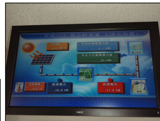
発電量を表示するモニター
