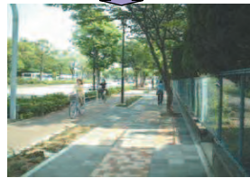
歩道、自転車道の整備
