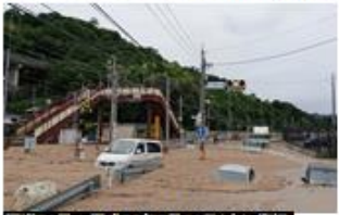
国道31号 平成30年7月11日(水) 復旧
