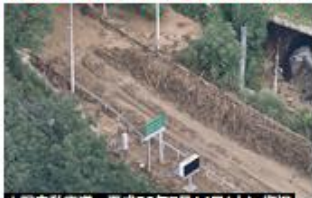
山陽自動車道 平成30年7月14日(土) 復旧
