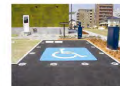
障がい者駐車場管理システム (運用中)
