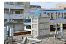
東西線妙典駅に設置した駅補助電源装置
