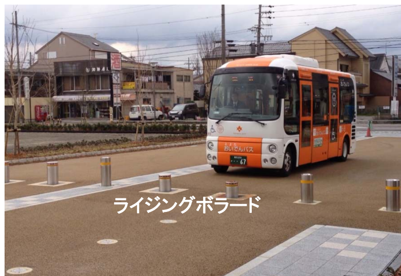
バス車両進入管理システム （運用中）
