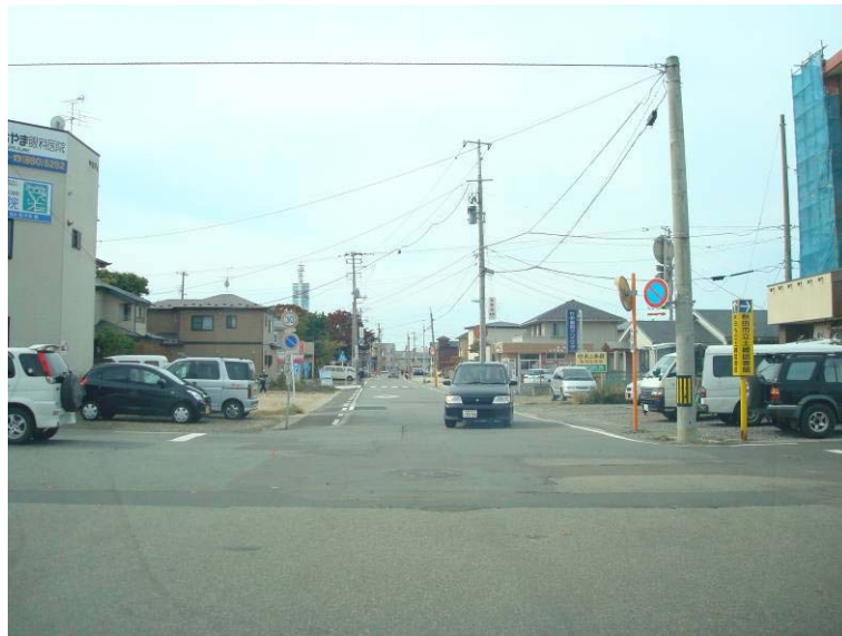
整備前 (建物移転後)
