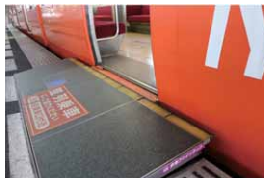
松山市駅・古町駅では、ホームと電車の際間の バリアを解消するため、ホームにラクーブ（可 動式スロープ）を設置。
