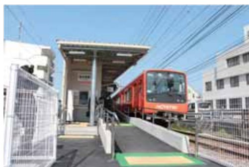
各駅での計画的なバリアフリー化を推進 （スロープ設置等）
