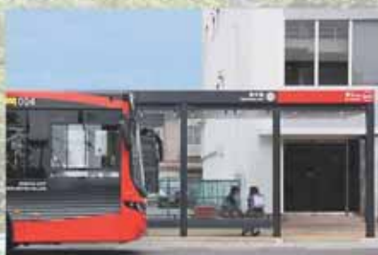
連節バス「ツインくる」とBRT駅 (新潟市、新潟交通株式会社)
