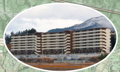
市営住宅中田団地
