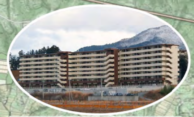
市営住宅中田団地
