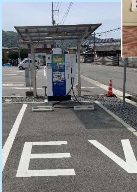
EV充電スタンドの設置(2015)
