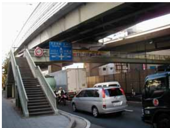
国道43号の大阪市港区弁天町駅前付近
