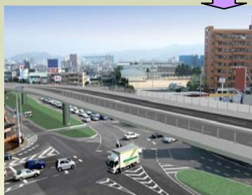
小坂交差点立体交差整備
